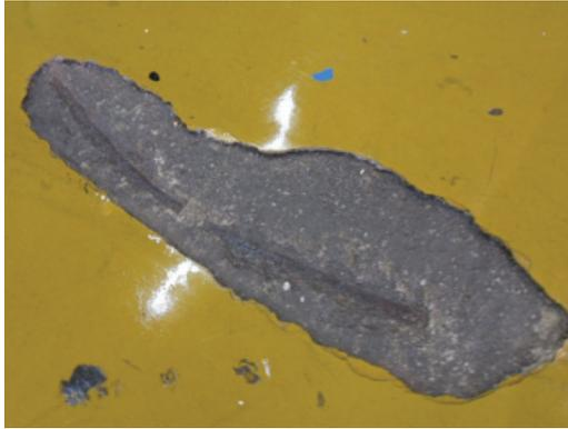
Figura 8: Buraco no piso de epóxi no edifício Vilanova Artigas
